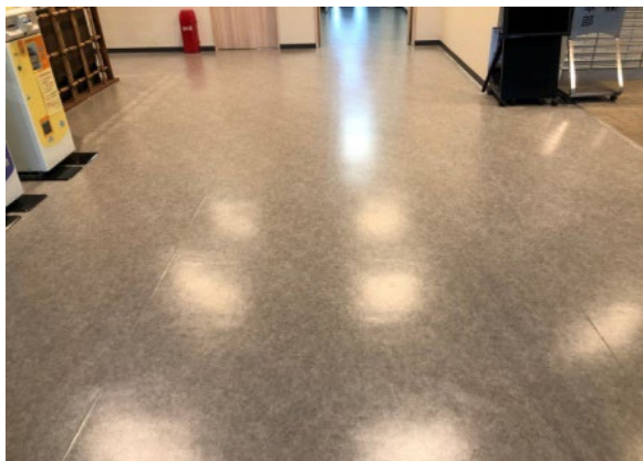
フロアシート改修
